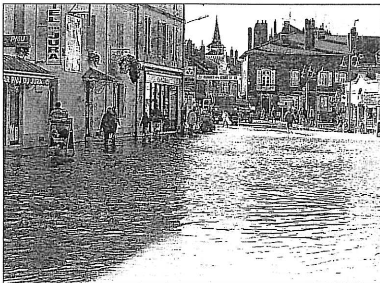
La rue d'Alsace sous les eaux
